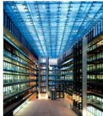
شكل (٢٤) الخلايا الفوتوفولتية بالسقف لتوليد الطاقة الكهربائية بمبنى شركة كهرباء مدريد
