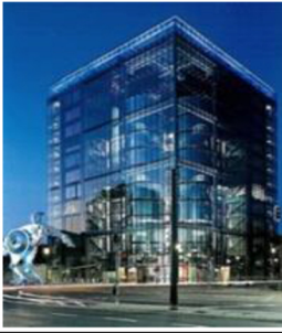
شكل (١٢) الواجهة الرئيسية لمبنى أكاديمية وسائط الطباعة 18 .
