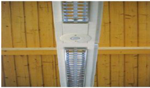
شكل (٣٢) حساسات الإضاءة بالسقف ٤٦
