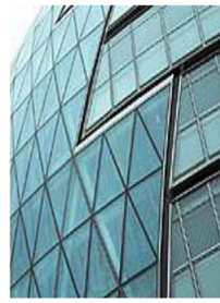
شكل (٢٩) الزجاج الخارجى للواجهات المعزولة حرارياً وصوتياً ٤٤ .
