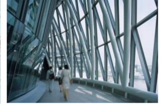
شكل (٢٩) الزجاج الخارجى للواجهات المعزولة حرارياً وصوتياً ٤٤ .
