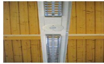
شكل (١٨) أجهزة استشعار الإضاءة بالسقف ٣٢ .
