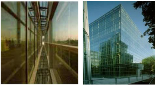
شكل (١٩) الغلاف الخارجى المزدوج للمبنى ويظهر الزجاج المصفح الملون.
