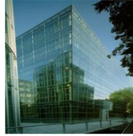
شكل (٣٥) الواجهة الخارجية لمبنى فيكتوريا بألمانيا ٤٨ .
