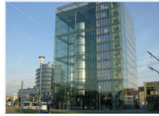
شكل (١٤) الغلاف الخارجي يظهر شفاف وخلفه الواجهة الأصلية للمبنى 20 .
