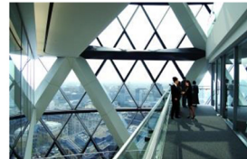
شكل (٢٢) الأغلفة المزدوجة لبرج Swiss Re Tower
