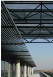
شكل (٢٤) الخلايا الفوتوفولتية بالسقف لتوليد الطاقة الكهربائية بمبنى شركة كهرباء مدريد
